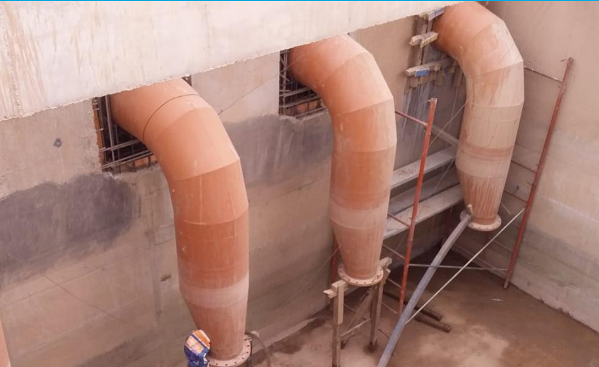
● Cañería interna en Estación de Bombeo
